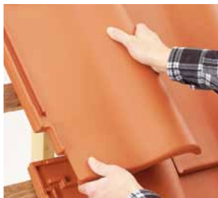
3. Ułożenie dachówek w kolejnym rzędzie.
