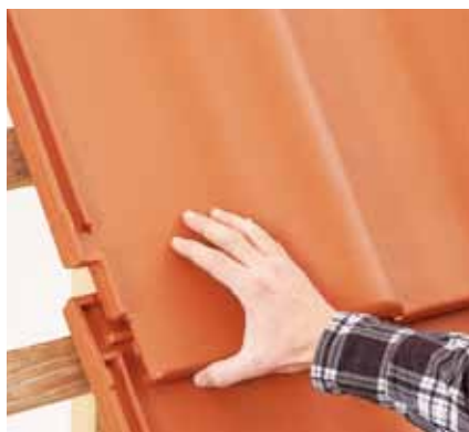
4. Dociśnięcie dachówki w celu zatrzaśnięcia spinki.
