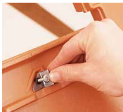
1. Umieszczenie spinki w odpowiednim wyprofilowaniu dachówki.
