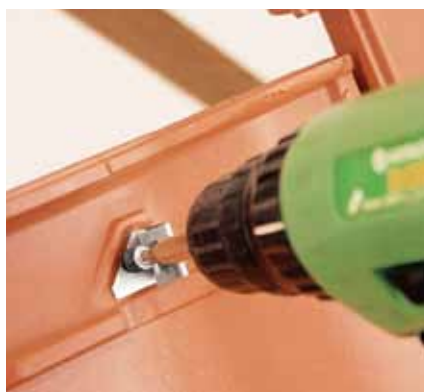
2. Przymocowanie dachówki i spinki za pomocą wkrętu.
