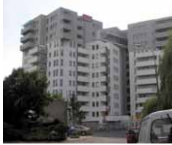
Apartamentowiec „Pelikan”, Poznań
