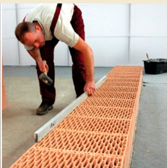
rys. 8. Wyrównanie pustaków w pierwszej warstwie wzdłuż ściany
