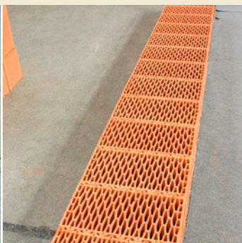
rys. 7. Ułożona pierwsza warstwa muru obwodowego
