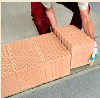
rys. 6. Układanie pierwszej warstwy pustaków
