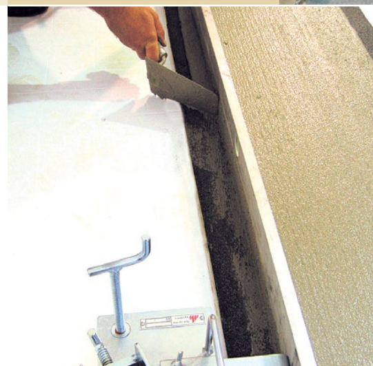
rys. 5. Usunięcie nadmiaru zaprawy
