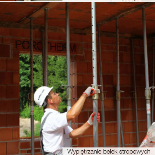
Montaż belek stropowych
