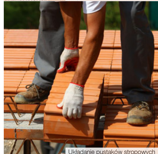
Układanie pustaków stropowych
