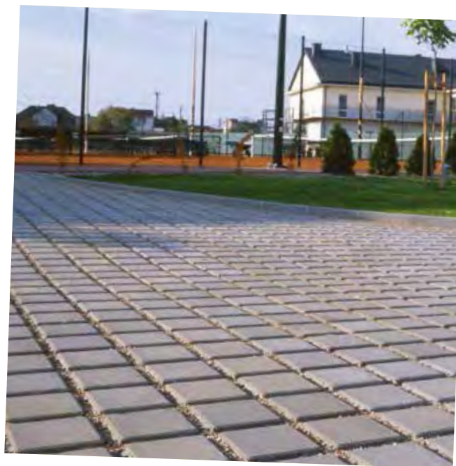
szeroka fuga ułatwiająca przedostawanie się wody
