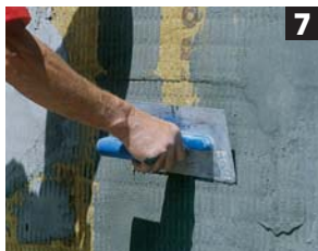
FASROCK LL – mocowanie płyt
